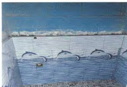
Foto 13: 13.1 Sustitución de azulejo
