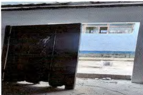
Foto 3: 4.3 Sustitución de Puerta
