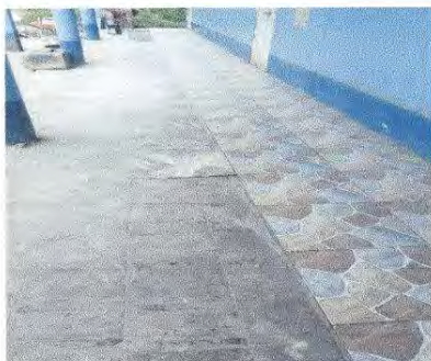
Foto7: 6.7 Sustitución de piso de granito
