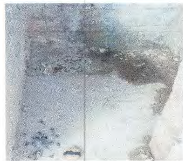
Foto 6: 6.6 Sustitución de piso líquido
