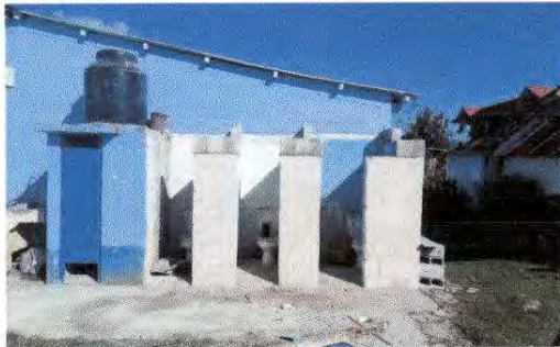
Foto 1: 2.2 Sustitución de Estructura de Madera por Metal
