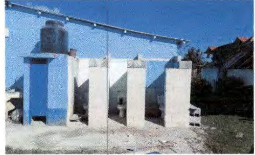
Foto 2: 4.3 Sustitución de Puerta
