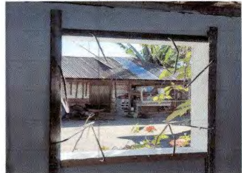
Foto 4: 5.3 Sustitución de ventana
