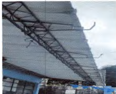
Foto 8: 7.2 Sustitución de canal de PVC
