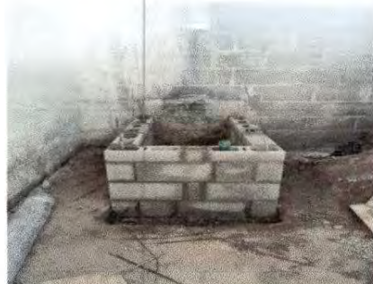
Foto14: 20.2 Sustitución de estufa rural incluye chimenea
