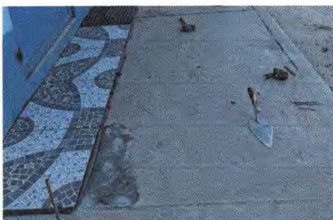
Foto 5: 6.5 Sustitución de piso de torta de concreto
